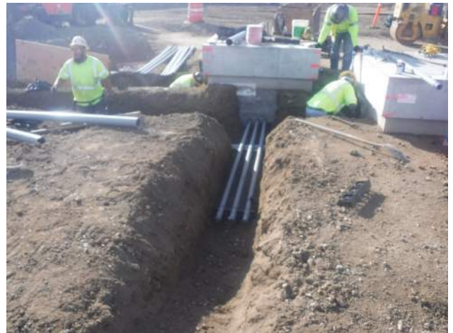
PE installing conduit pipes at PB9
