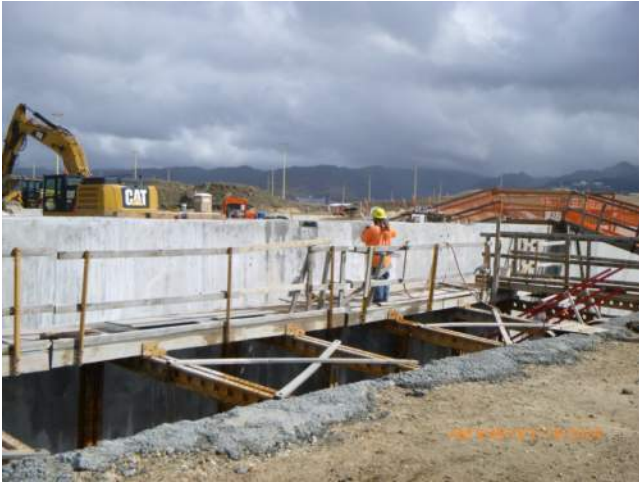
KIWC dry finishing the surface of CWCB pour #23.
