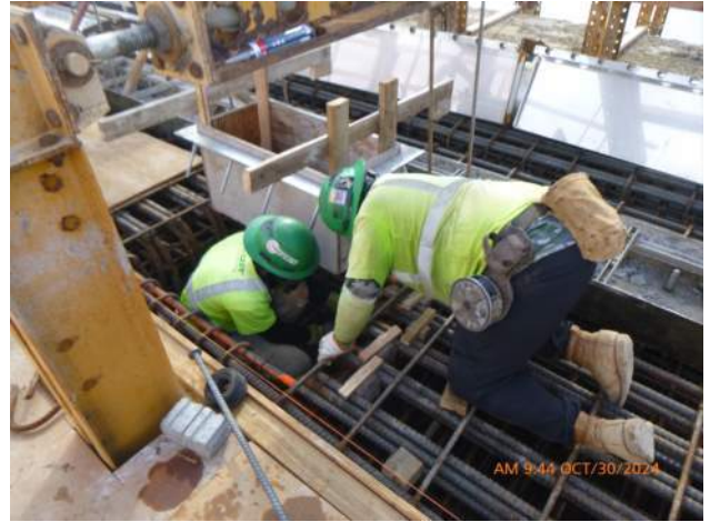
HRSPI installing rebar for WSCRB pour #A1.
