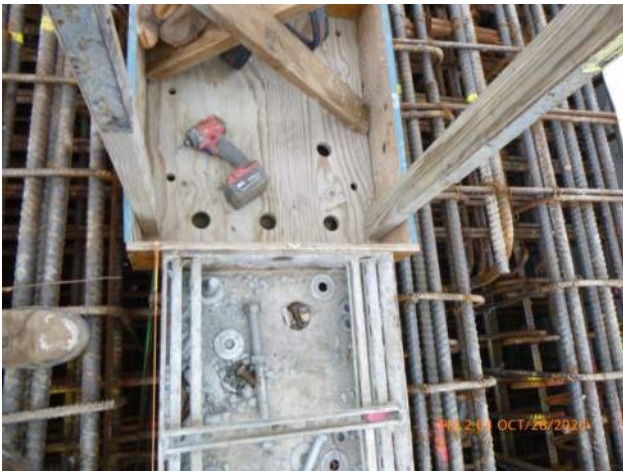
KIWC installing formwork for WSCRb pour #A1.
