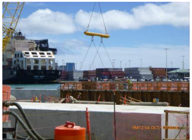
KIWC stripping formwork from CWCB pour #24.
