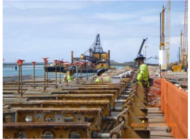
KIWC installing formwork for WSCRb pour #A1.
