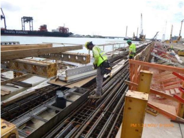
KIWC setting formwork for WSCRb pour #A1.
