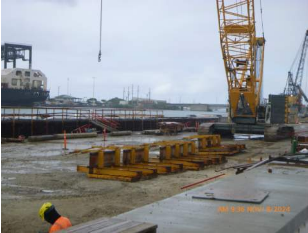
KIWC installing formwork for WSCRB pour #A2.
