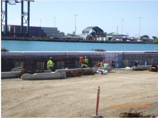
HRSPI installing rebar for WSCRB pour #A4.
