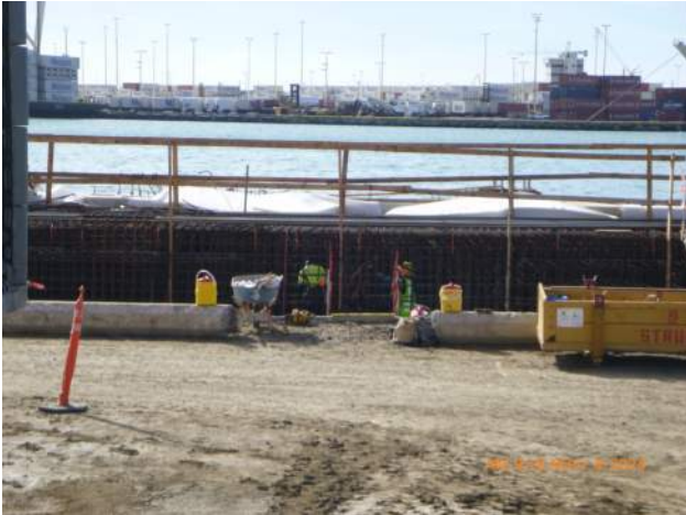
HRSPI installing rebar for WSCRb pour #A2.
