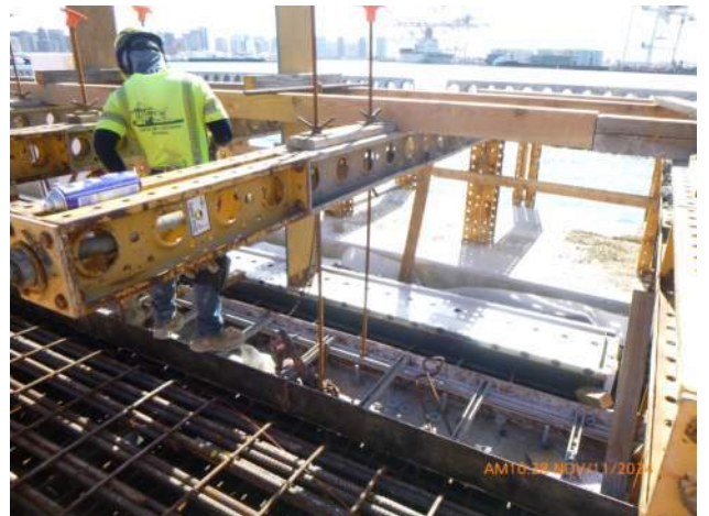
KIWC setting anchors in the WSCRB pour #A1 crane rail pocket.
