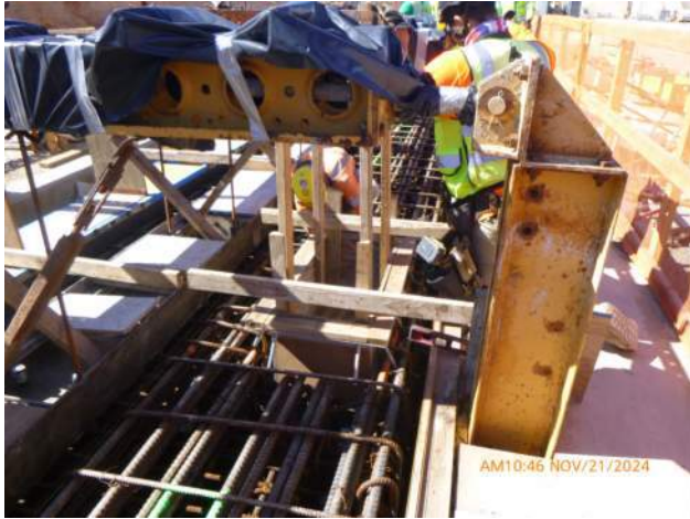
KIWC prepping for WSCRB pour #A1.
