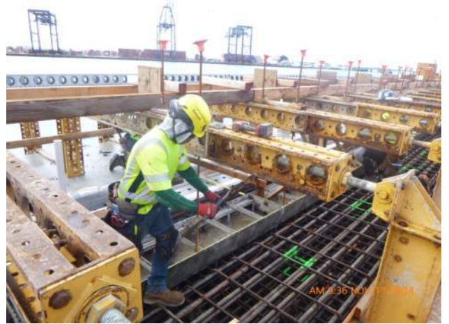
KIWC setting the crane cable trench in WSCRB pour #A1.
