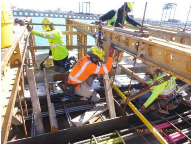
KIWC setting formwork for WSCRB pour #A2.
