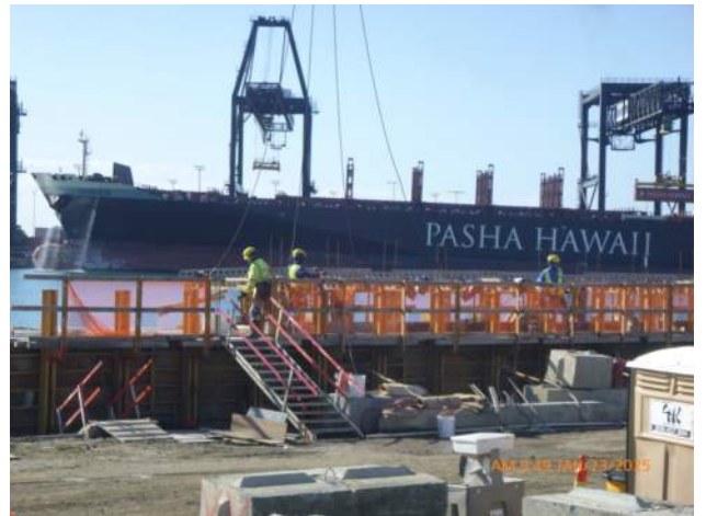
KIWC removing formwork from around WSCR pour #A3.
