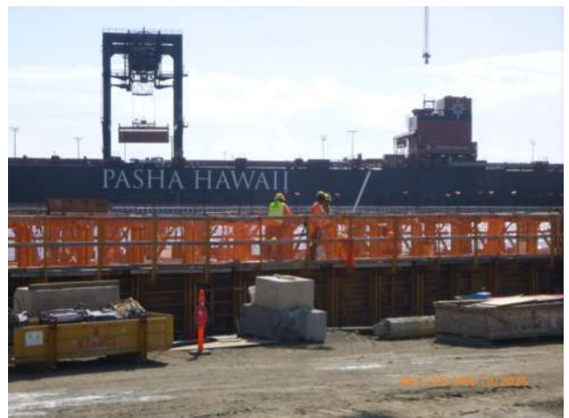
KIWC installing formwork for WSCRb pour #A3.
