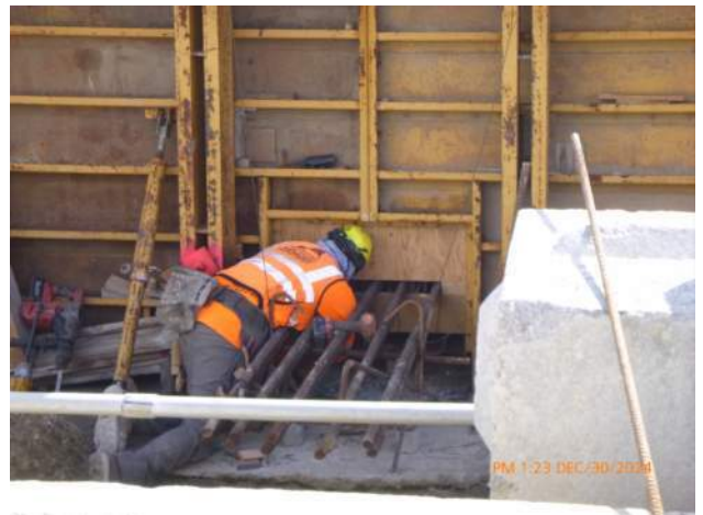
HRSPI resetting embedded tie beam rebar in WSCRb pour #A2.
