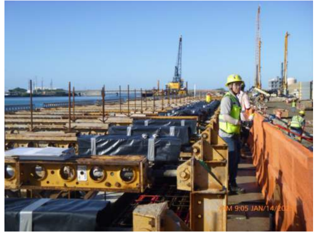
KIWC cleaning formwork for WSCRB pour #A2.
