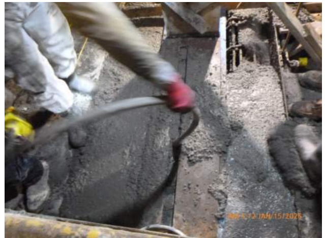
KIWC pouring concrete for WSCRB pour #A2.
