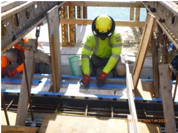
KIWC prepping formwork for WSCRB pour #A2.
