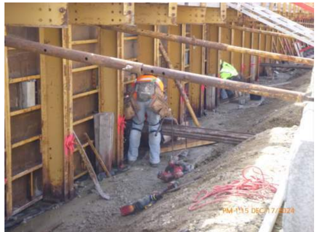
KIWC resetting the embedded tie beam rebar in WSCRB pour #A2.
