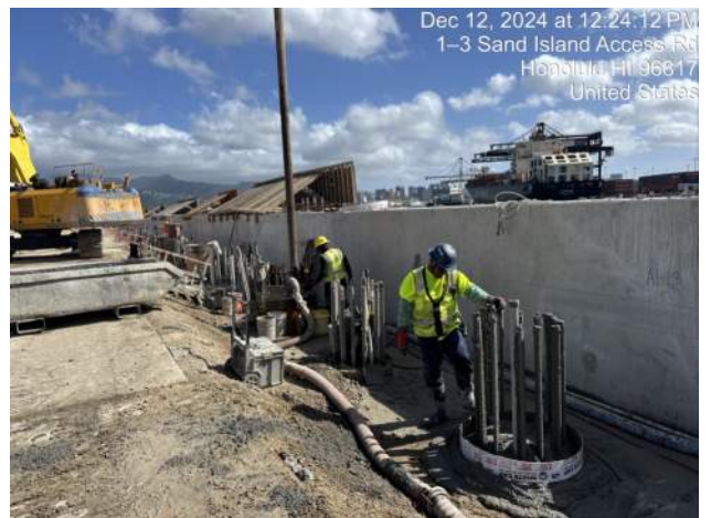
KIWC pouring CIDH shaft 15-A1-36
