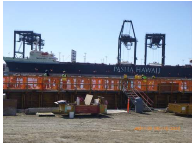
KIWC setting formwork for WSCRB pour #A3.
