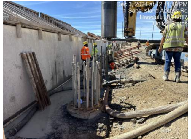
KIWC progress pouring CIDH 28-A1-36
