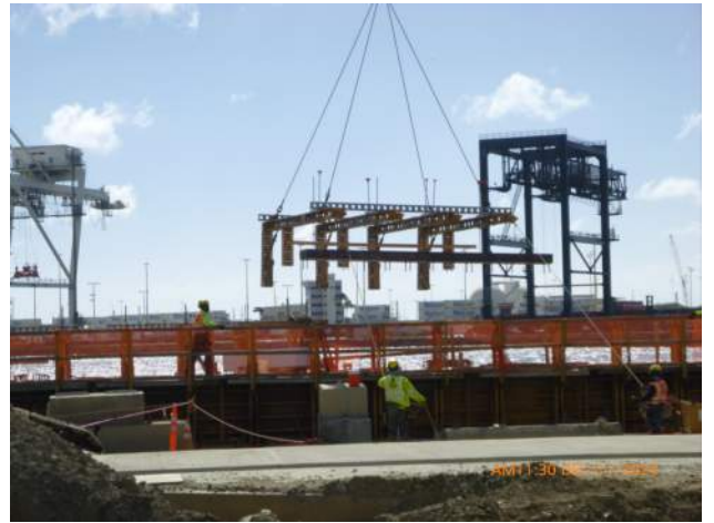
KIWC installing yokes over the WSCRB pour #A2 formwork.
