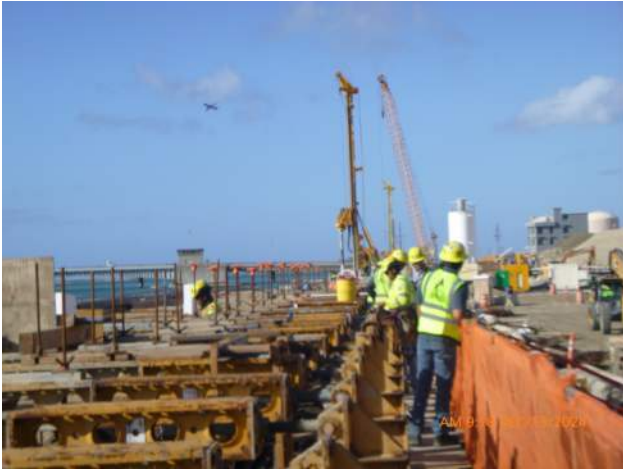
KIWC installing formwork for WSCRB pour #A3.
