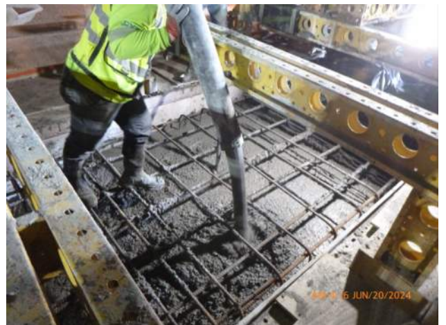
KIWC pouring concrete for capping beam pour #21.
