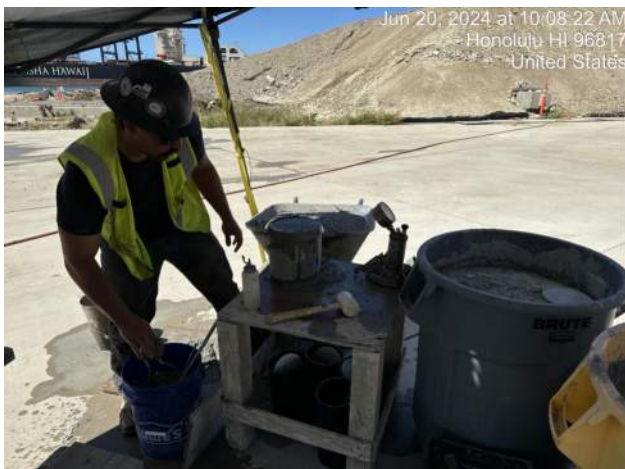
MPE testing truck 2 of the CIDH pour
