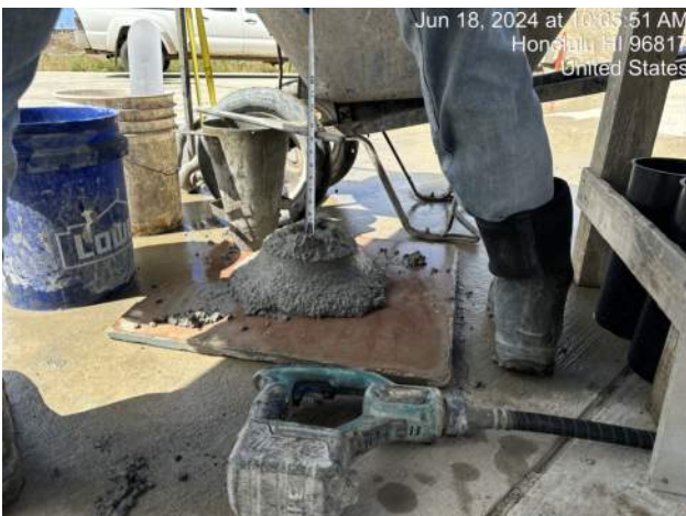
MPE testing truck 1 of the CIDH pour
