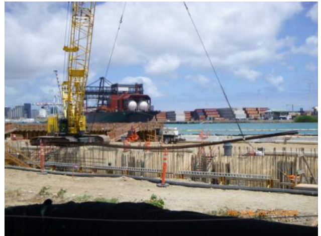
HRSPI setting rebar for LSCRB pour #7.
