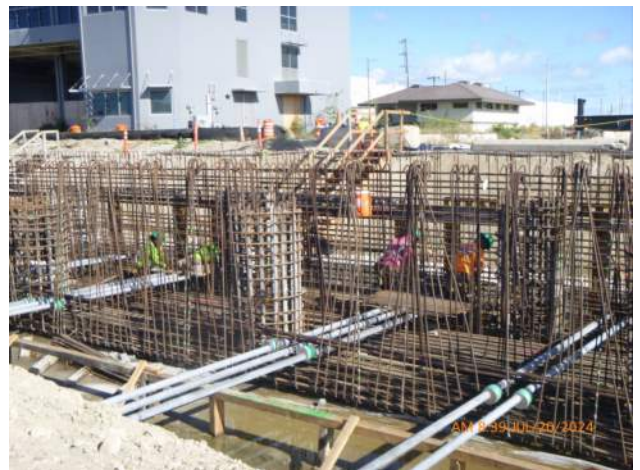
HRSPI installing rebar for LSCRB pour #7 on pier 43.
