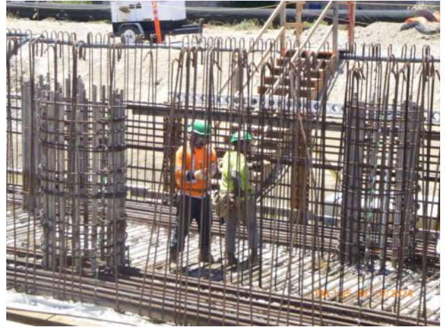
HRSPI installing rebar cage for LSCRB pour #7.
