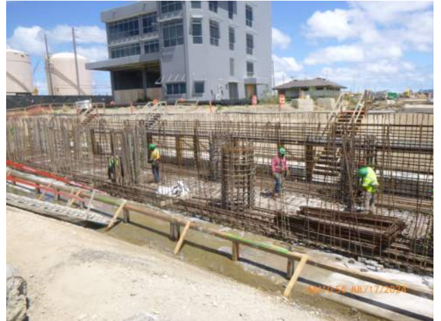
HRSPI installing rebar for LSCR B Pour #7.
