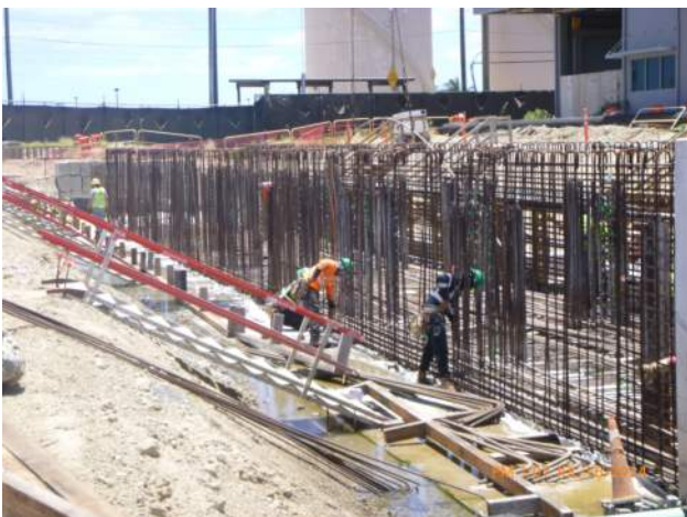
HRSPI setting rebar for LSCRB pour #7.
