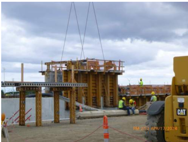
KIWC moving formwork from capping beam pour #15 to pour #17.
