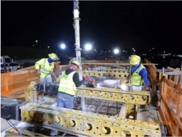
KIWC pouring capping beam pour #16.
