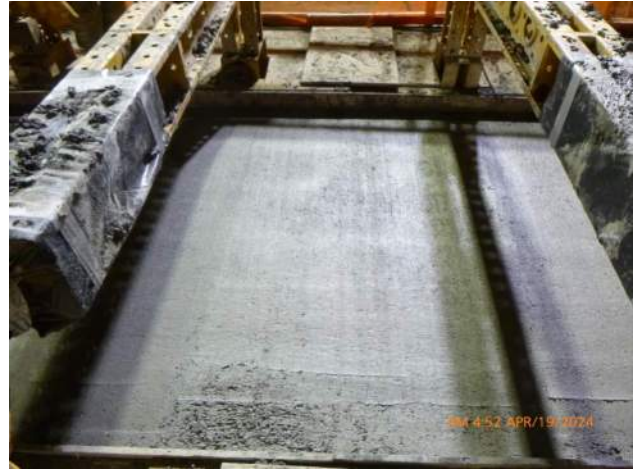
KIWC finishing the surface of capping beam pour #16.
